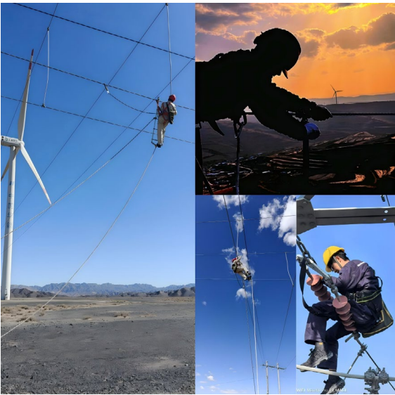
自主线路检修
